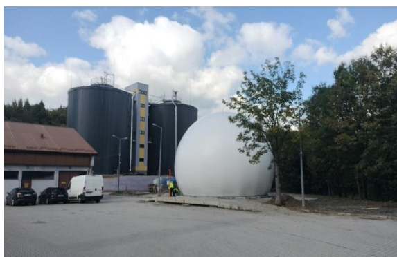
Fot. Komory fermentacji na oczyszczalni Łęgi
