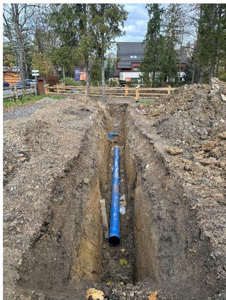
Fot. Przebudowa wodociągu w ul. Jagiellońska Kotelnica
