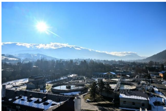
Fot. Oczyszczalnia ścieków
