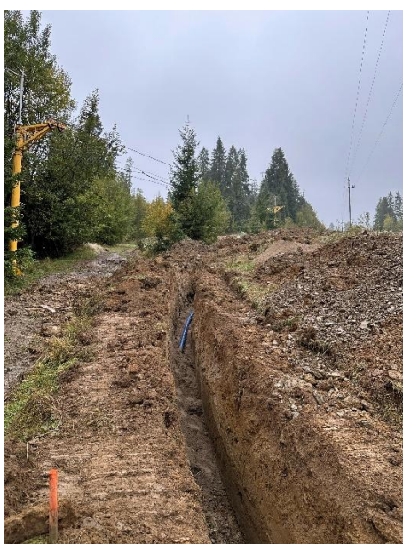
Fot. Budowa wodociągu Gubałówka –
